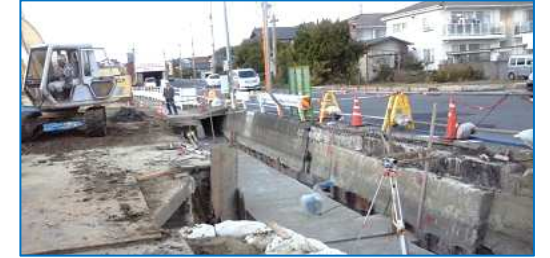
学区内での道路工事(二本松交差点北)
